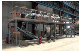
FRANCE | Canopée - 1/3,66 ème Cascade de la Canopée du Forum des Halles
